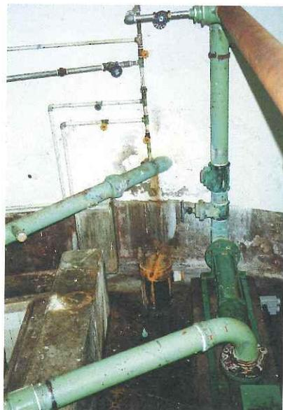
Foto 27 - Captação por poço tubular da fonte Andrade Júnior. As tomas d'água encontram-se na coluna do revestimento.
