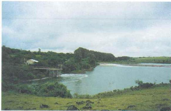
Foto 7 - Lagoa de lançamento de efluentes de metalurgia da CBMM (Barragem 4). Ao fundo, zona assoreada da barragem.
